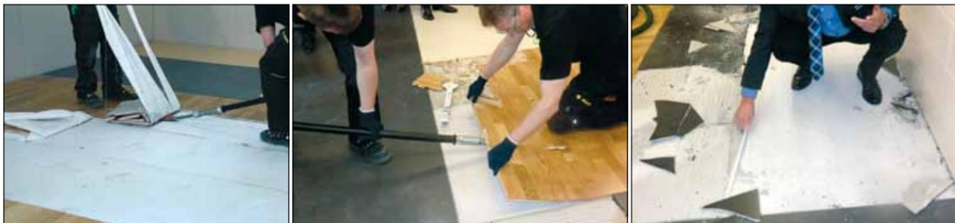
Um den Belag später wieder zu entfernen, werden die Verbindungsnahte durchgeschnitten und das obere Gewebe mit dem Belag entfernt. Zurück bleibt die glatte Grundschicht, auf die in der Regel ohne weitere Spachtelarbeiten ein neuer Belag entweder konventionell oder erneut mit diesem System aufgebracht werden kann.
