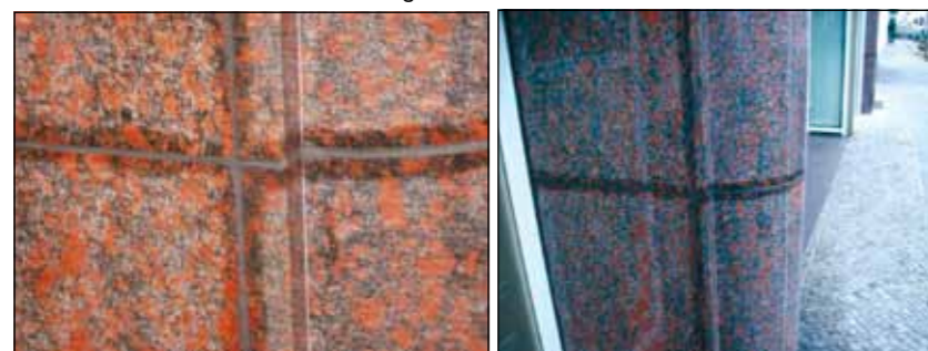
Schadensbilder der Randzonenverfärbungen an Natursteinfassaden
