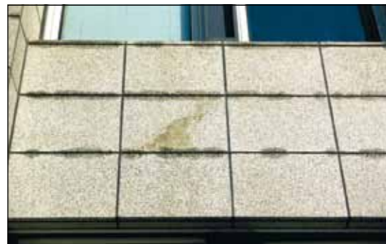
Diese Bilder zeigen Beispiele für die optische Beeinträchtigung der gesamten Fassade durch Randverfärbungen, die nur durch Rückbau zu beseitigen sind.
