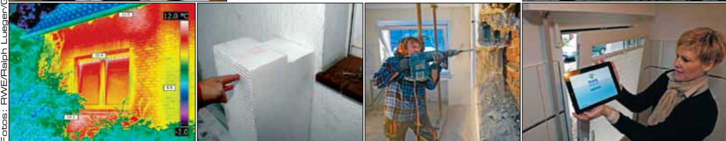
NRW-Bauminister Groschek ließ es sich nicht nehmen, gemeinsam mit Bottrops Oberbürgermeister Tischler dem Ehepaar Kewitsch den Schlüssel für ihr altes/neues Eigenheim zu übergeben. Die Thermografie zeigt die Schwachstellen der Außenwand, was mit einem 30 cm dicken Dämm-Panzer behoben wurde. Dabei blieb kein Stein auf dem anderen. Und wo Herr Kewitsch einstmalig seinen Wein vortrug, herrscht jetzt die Elektronik, derweil sich Gattin Beate mit der Fenster- und Licht-Bedienung via Tablet-PC vertraut macht.
