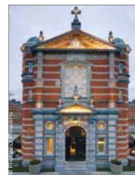
Das Äußere der Kapelle des ehemaligen Militärlazaretts ist kaum verändert worden. Erst beim Betreten gibt es sein Geheimnis preis: Das Gourmetrestaurant The Jane mit seiner Sterne-Küche verströmt trotz seiner trendigen Einrichtung eine geradezu sakrale Aura.
