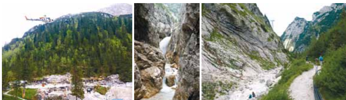
Hubschrauber als Baustellenkran: Das alpine Gelände ließ den Baustellen-Logistikern keine Chance. Alle Baustoffe und Bauteile für die neue Hütte kamen aus der Luft.
