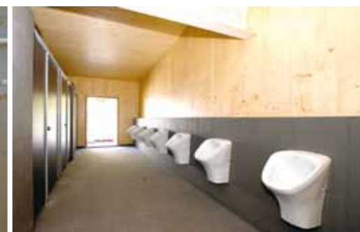
Nicht nur weil es typisch für die Region ist, war Holz wesentliches Baumaterial für Rohbau und Innenausbau. Denn die Möglichkeit der Vorfertigung im Tal erleichterte die Anlieferung per Hubschrauber.
