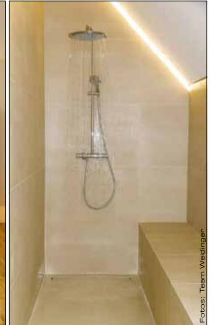
Fast unsichtbar ist der Ablauf in der Dusche: ein schlichter Spalt am Boden, aber er schluckt auch bei einem großen Duschkopf zuverlässig das Wasser. Für warme Füße und einen trockenen Boden sorgt die Fußbodenheizung, die bis zur Duschrinne reicht.
