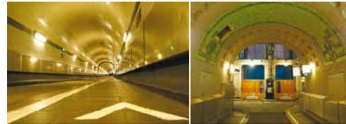
bilden, wird nun die erste von zwei Röhren komplett saniert. Die neuen Fliesen an Wänden und Deckengewölbe greifen die ursprüngliche Gestaltung wieder auf.
