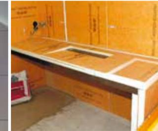
Links und oben: Der unterfahrbare Waschtisch wurde komplett aus dem Fliesen-Verlegeuntergrund Kerdi-Board erstellt. Der Ablauf ist eine Anleihe aus der Dusche: die Linientwässerung „Kerdi-Line“
