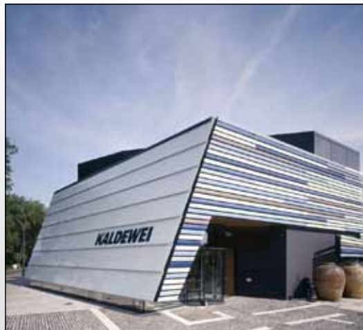
Im Kaldewei Kompetenz Center in Ahlen finden jährlich rund 250 Veranstaltungen statt. Das Gebäude hat sich im Laufe der Zeit von einem Schulungszentrum zu einer beeindruckenden Markenwelt mit jährlich rund 4.000 Besuchern entwickelt.
