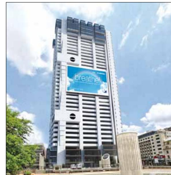
Ein Megaposter informiert über die spezielle Eigenschaft dank der Titandioxid-Veredelung, mit der die Fassadenkeramik bereits ab Werk versehen ist. „Neue Keramikfassade für saubere Luft“ ist da zu lesen, denn ähnlich einem Wald mit Laubbäumen würden Luftschadstoffe abgebaut, das Bauwerk soll somit als eine Art „vertikaler Stadtwald“ fungieren.
