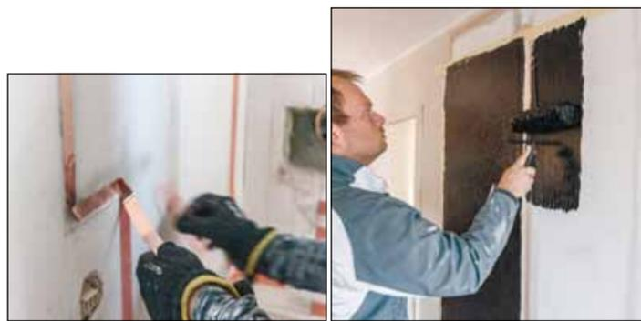
Dieser wird an das Stromnetz angeschlossen und mit einem Steuergerät verbunden. Es handelt sich um eine sogenannte Flächenheizung, die nicht punktuell heizt, sondern die Wärme großflächig und gleichmäßig im Raum verteilt. Ein Effekt wie bei einer Fußbodenheizung. Allerdings erwärmt der Heizanstrich nicht die Luft, sondern sendet langwellige Wärmestrahlung (Infrarot) aus, die Lebewesen und Gegenstände direkt erwärmt. Für ein wohlige Wärmeempfinden genügt eine um mehrere
