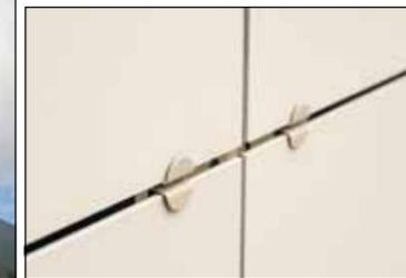
Räume das Tageslicht maximal ausgenutzt. Insgesamt wurden 7 000 m<sup>2</sup> Fassade mit dem sehr dünnen Feinsteinzeug „XLight“ mit dem Verankerungssystem von Butech aus der spanischen Porcelanosa Gruppe verkleidet. Die nur 3,5 mm dünnen Platten im Format 100 x 300 cm wiegen jeweils nur 8 kg/m<sup>2</sup>. Optisch überzeugen die Platten XLight Basic in dem Farbton „Nature“ durch eine gleichmäßige Oberfläche, die durch die Farben XLight Basic Sand und XLight Basic Dark attraktiv variiert wird.
