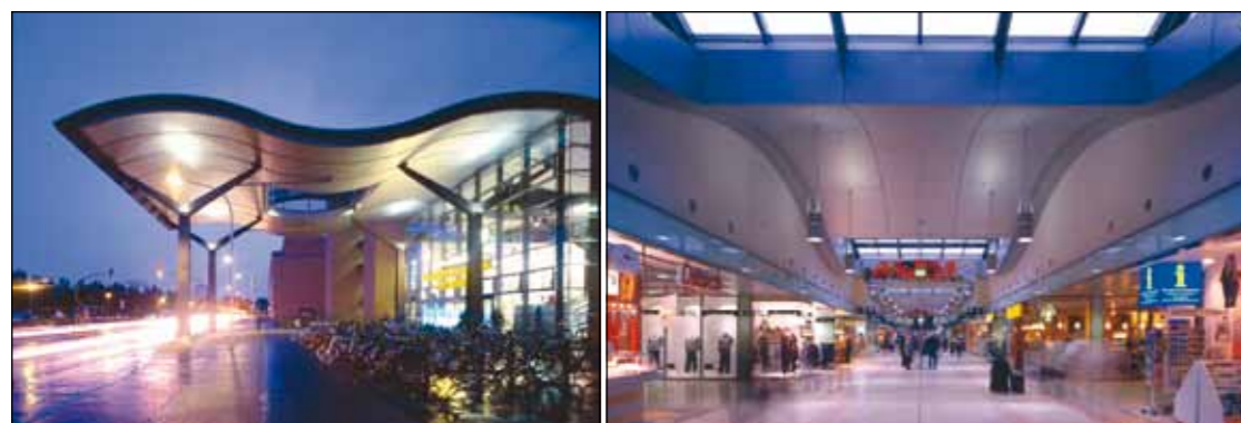
Längst nicht mehr zeitgemäß und dem neuen Stadtbild angepasst finden die Potsdamer den schwungvollen Vorbau des Bahnhof-Haupteingangs. Er wird im Zuge der Modernisierung verschwinden. Und auch wird nicht nur der Bodenbelag auf Vordermann gebracht.
