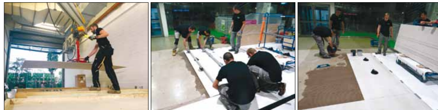
Abschnitt für Abschnitt wird der alte Bodenbelag abgeschliffen, werden Unebenheiten und Risse gespachtelt und anschließend neu belegt. In einem separaten werkstatmäßig ausgestatteten Raum werden die Platten gelagert und nötigenfalls zugeschnitten. Die Verlegung erfolgt mit speziell hierfür entwickelten mit Saugnäpfen bestückten Aluminiumschienen.
