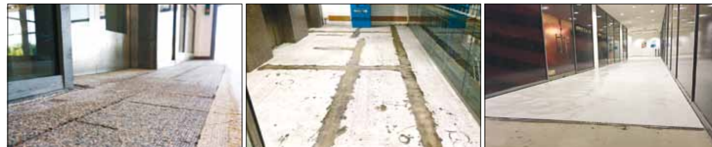
Abschnitt für Abschnitt wird der alte Bodenbelag abgeschliffen, werden Unebenheiten und Risse gespachtelt und anschließend neu belegt. In einem separaten werkstatmäßig ausgestatteten Raum werden die Platten gelagert und nötigenfalls zugeschnitten. Die Verlegung erfolgt mit speziell hierfür entwickelten mit Saugnäpfen bestückten Aluminiumschienen.
