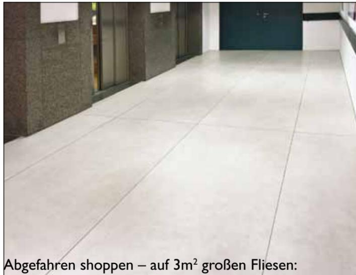
Sie bilden für alle Bahnreisenden das Eingangstor zur Hauptstadt des Landes Brandenburg: die „Bahnhofspassagen Potsdam“. Derzeit wird im Rahmen einer Nachtbaustelle der gesamte Bodenbereich auf einer Fläche von nahezu 4 500 m<sup>2</sup> erneuert und mit großformatigen Fliesen attraktiver gestaltet.
