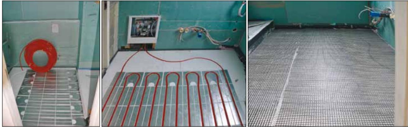
Auf den vorbereiteten Untergrund werden die Rohrträger-Elemente mit den Nuten für die Heizleitungen verklebt. Sie sind so ausgebildet, dass die Rohre ohne weitere Hilfsmittel sicher fixiert sind. Anschließend wird über die Bodenfläche Glasfaser-Entkopplungs- und Armierungsmatte geklebt (Fotos rechts).
