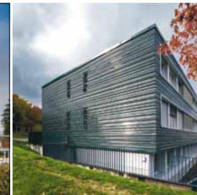
Foto links: Die Fassaden-Sanierung (hier: Haus C) überzeugt durch Nachhaltigkeit und Ästhetik unter Wahrung architektonischer Wurzeln wie z.B. die horizontale Betonung durch quer verlegte Keramikfliesen und breite Fensterriegel.
