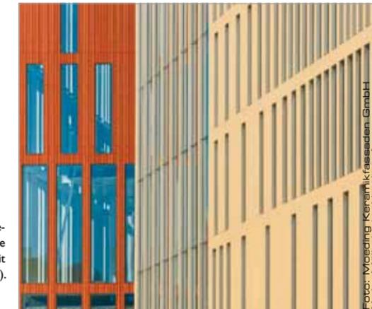
Durch den Einsatz einer vorgehängten hinterlüfteten Fassade entstand eine leichte Hülle mit textilen Qualitäten (rechts).
