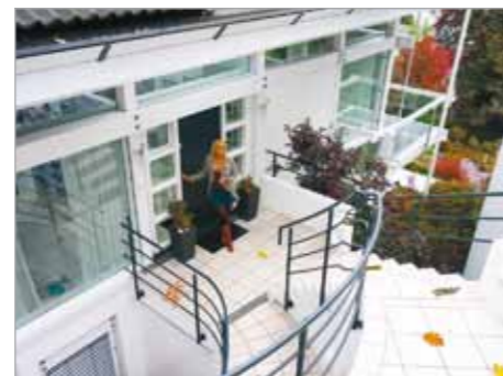
Vermieter müssen dafür Sorge tragen, dass ihre Mieter einen sicheren Zugang zum Gebäude haben. Bei Nässe kann allerdings ein attraktiver Außenbereich mit mineralischen Böden rutschig werden.
