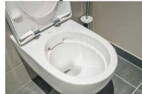
Ein so genannter keramischer Spülverteiler leitet das Spülwasser symmetrisch im WC-Becken nach rechts und links sowie abwärts direkt in den Siphon.
