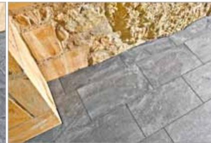
Maßarbeit im Spa-Bereich: Die Fliesen mussten sehr sorgfältig an die Gegebenheiten der Sandsteinmauern angepasst werden.
