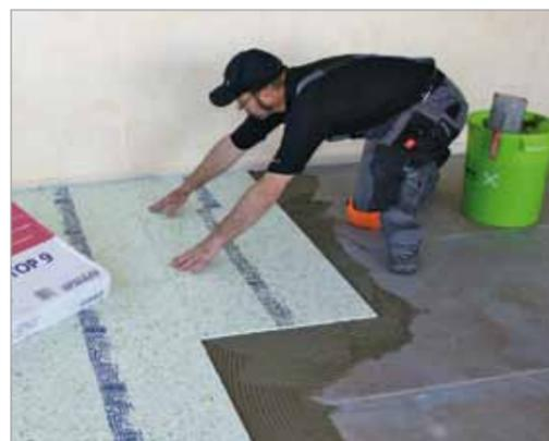
Vollständige Entkopplungen wie zum Beispiel mit kunstharzgebundenen Polyesterfaser-Pressplatten (hier: „Uzin Multimoll“) unterbrechen den Verbund zwischen Untergrund und Oberbelag, sodass sich die Schichten relativ unabhängig voneinander bewegen können.
