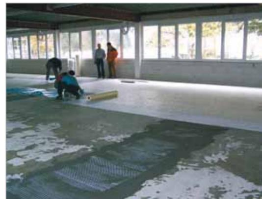
Das Gesamtsystem einer Versteifung wird durch den intensiven Verbund aller Komponenten zusammengehalten. Das Renoviervlies besteht aus in alle Raumrichtungen ausgerichteten, 50 Millimeter langen und alkalibeständigen Glasfasern. Nach dem Ausgießen der Spachtelmasse auf das lose verlegte Renoviervlies löst sich das Bindemittel, welches die Fasern der Matte zusammenhält, mit dem Anmachwasser.
