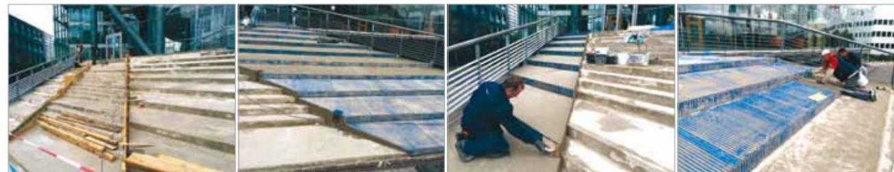
Szenen einer Renovierung: Nach dem Entfernen des Altbelages wurden Fehlstellen der Rohbaukonstruktion ausgebessert, bevor mit dem Ausbau des neuen Belages begonnen wurde. Erkennungsmerkmal des verwendeten Systems: das blaue Gewebe, das auf die Tragstege aufgelegt wird. Unten eine schematische Darstellung des Systems.
