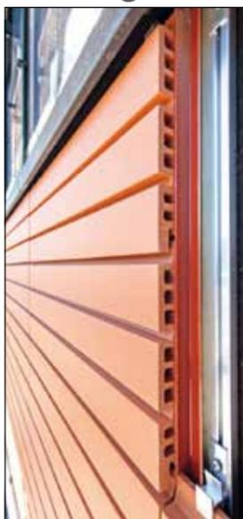
Links: Die keramischen Terzo-Fassadenplatten in der Scherbenfarbe Lachs-/Pastellrot wurden auf die vertikal aufgebrachte Aluminium-Tragkonstruktion montiert.
