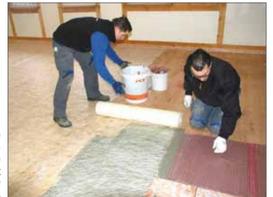
Der besondere Clou von glasfaserverstärkten Armiermatten ist ein spezielles Bindemittel, das die alkaliresistenten Glasfasern im Lieferzustand in Mattenform zusammenhält und sich bei Kontakt mit der frischen Bodenausgleichsmasse ohne störende Wirkung auflöst. Die Armierungsfasern verbleiben konzentriert und flächig in alle waagerechten Richtungen wirkend im unteren Grenzflächenbereich und können von der Bodenausgleichsmasse vollständig umhüllt werden.
