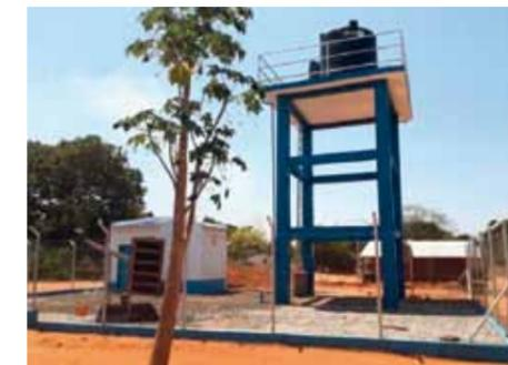
werden 9 500 Menschen über ein Wasserversorgungssystem mit zwei manuell betriebenen Pumpen und einem Verteilerzentrum mit einer Speicherkapazität von 15 m³ mit Trinkwasser versorgt. Die Entnahme erfolgt über vier öffentliche Zapfstellen, vier Anschlüsse in öffentlichen Einrichtungen und 32 Hausanschlüsse. Vom Verkauf ausgewählter Produkte fließt ein Teil der Einnahmen an die Trink-
