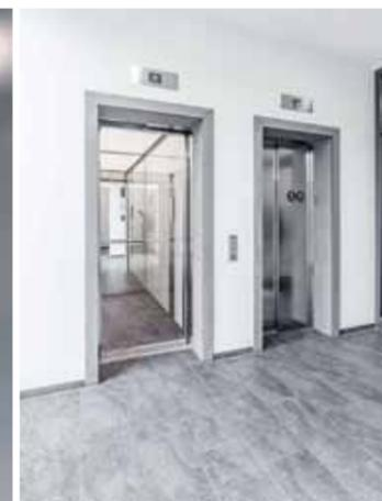
Die stark frequentierten Verkehrswege bis hinein in die Fahrstühle sowie die Treppen wurden mit besonders belastbaren Feinsteinzeugfliesen mit Rutschhemmung R10 ausgestattet.
