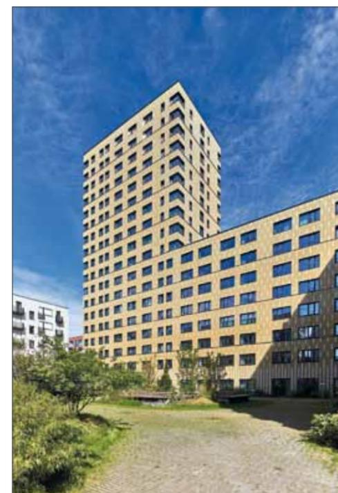
Die speziell entwickelten und gefertigten keramischen Schenkelpatten ermöglichen technisch und optisch stringente Ecklösungen, die der Gebäudehülle souveräne Homogenität verleihen.
