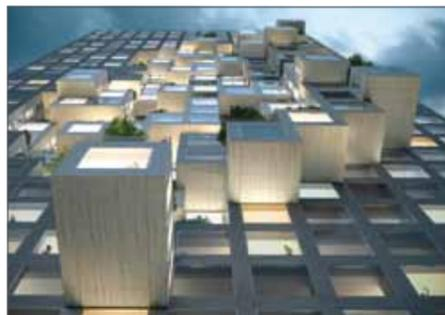
Die großen Glasflächen der Fassade werden gerahmt von Elementen aus Basaltstein, die mit rund 85 000 Hinterschnittankern befestigt werden. Für Fassadenbauingenieur Altin Mico von 3V Mico (Albanien) ermöglichen sie eine verdeckte Befestigung und können zugleich die in Auszugsversuchen ermittelten hohen Lasten aufzunehmen.
