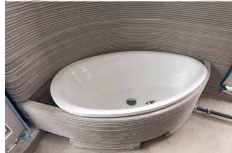
Die Wannenschürze wurde entsprechend den vorgegebenen Daten mit den erforderlichen Aussparungen mit einer solchen Präzision gedruckt, wie es bei traditioneller Bauweise kein Maurer hinbekommen würde. Unten rechts das fertige Badezimmer.
