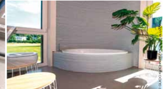
Die Wannenschürze wurde entsprechend den vorgegebenen Daten mit den erforderlichen Aussparungen mit einer solchen Präzision gedruckt, wie es bei traditioneller Bauweise kein Maurer hinbekommen würde. Unten rechts das fertige Badezimmer.
