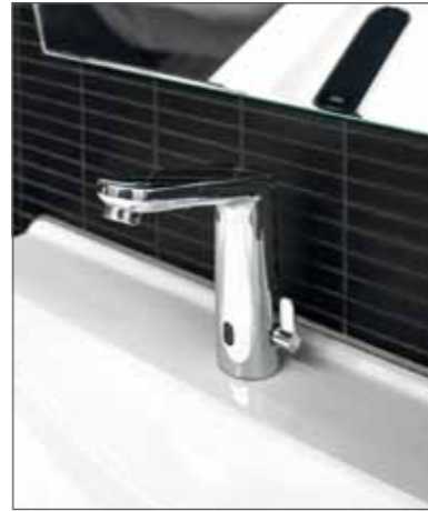
Die Waschtischarmaturen wurden passend zu dem smarten Gebäude ausgewählt. Sie überzeugen nicht nur durch ihr zeitloses Design, sondern entlasten auch das Gebäudemanagement. (Foto: Daniele Ansidei)
