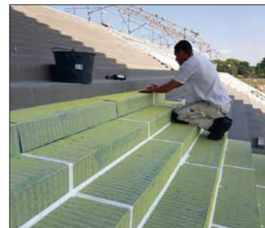
Um die zu erwartenden großen Mengen Niederschlagswasser ableiten zu können wurde eine kapillarpassive Drainage verlegt (links), auf die anschließend der Epoxidharz-Drainmörtel aufgebracht wurde.
