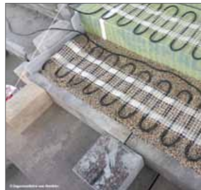
Das Problem der neuen Elektroheizung wurde mit einer Sonderkonstruktion gelöst. Die Heizungsschleifen liegen jetzt auf einer Gittermatte und mussten ganz vom Drainmörtel umschlossen werden
