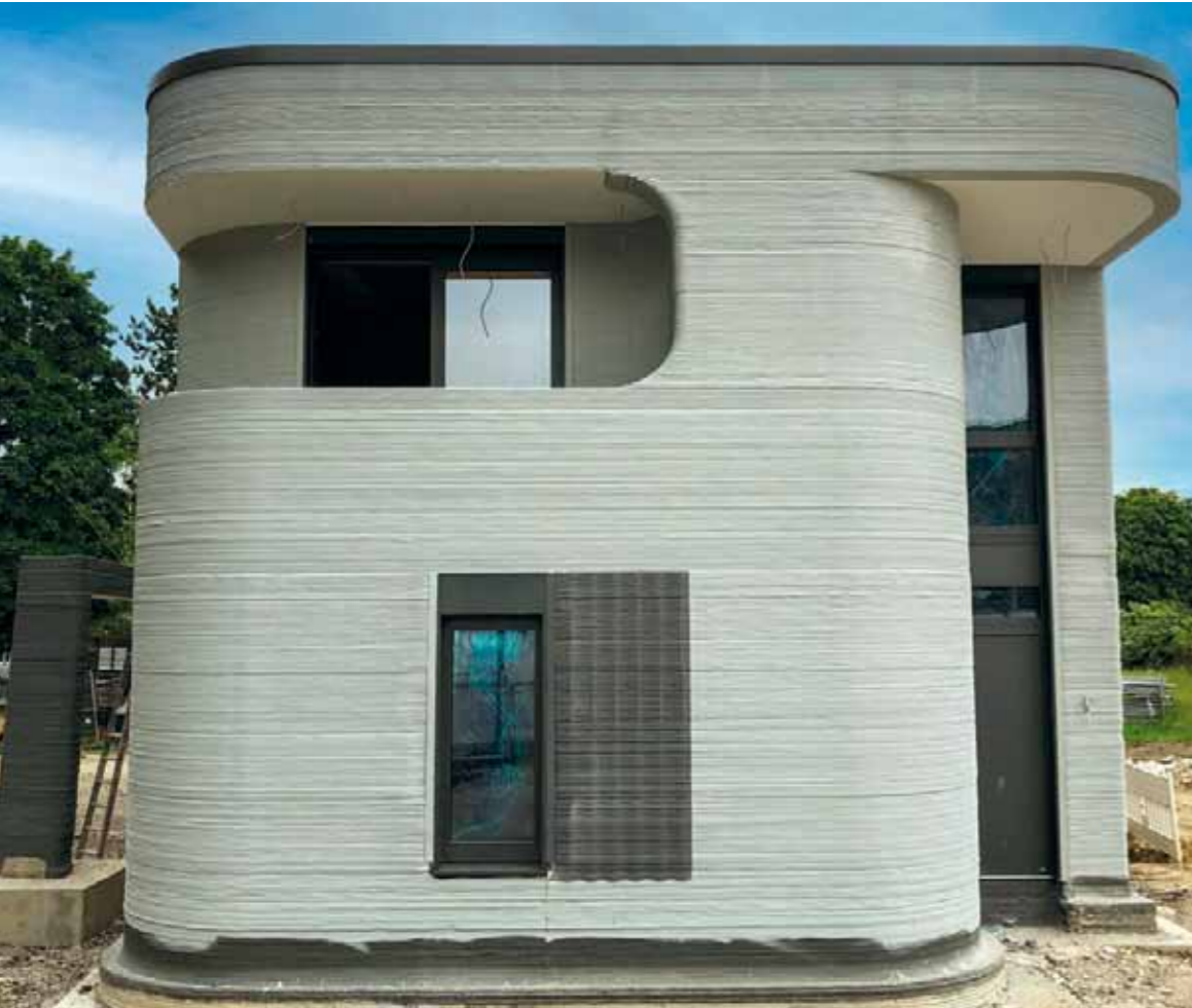
Der Rohbau des ersten im 3D-Verfahren gedruckten Einfamilienhauses, das Ende Juli 2021 nach 8 Monaten Bau- (resp. Druck-)zeit fertiggestellt wurde. Besonderes Merkmal: Der sonst im Bauwesen omnipotente Rechte Winkel spielt hier eher eine Nebenrolle. Fotos unten: Ein Blick in die etwas andere Baustelle und der „Bauarbeiter“, die Druckerdüse.
