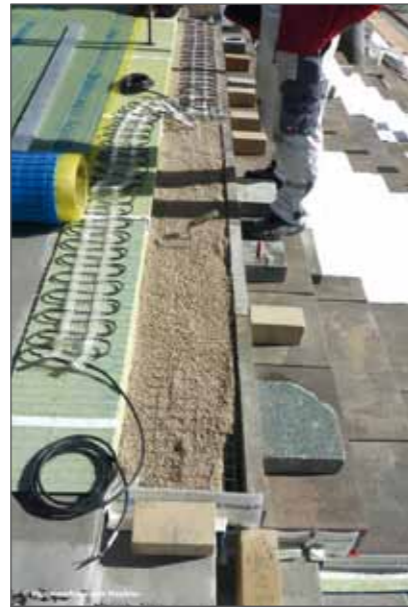
Das Problem der neuen Elektroheizung wurde mit einer Sonderkonstruktion gelöst. Die Heizungsschleifen liegen jetzt auf einer Gittermatte und mussten ganz vom Drainmörtel umschlossen werden
