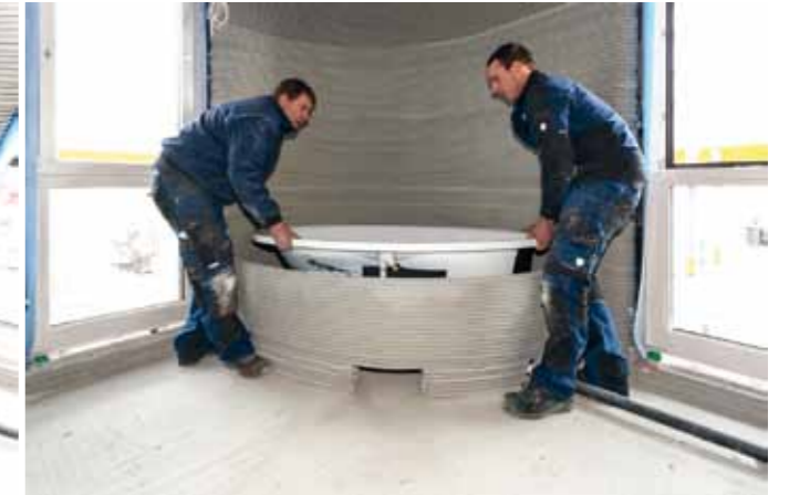
Die Wannenschürze wurde entsprechend den vorgegebenen Daten mit den erforderlichen Aussparungen mit einer solchen Präzision gedruckt, wie es bei traditioneller Bauweise kein Maurer hinbekommen würde. Unten rechts das fertige Badezimmer.
