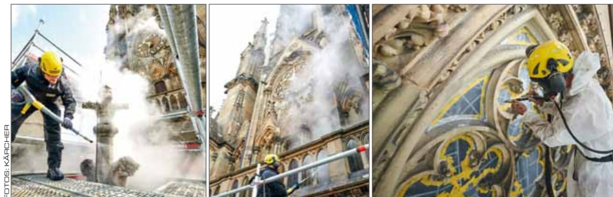
Die um Laufe der Zeit entstandenen Ablagerungen werden substanzschonend und mit verschiedenen Reinigungstechniken entfernt, unter anderem mit Hilfe von Heißwasser-Hochdruckreinigern in der schonenden Dampfstufe mit 95 °C und einem reduzierten Druck von maximal 0,5 – 1 bar. Schwarze Krusten und Manganverfärbungen werden mit dem Niederdruck-Partikelstrahlverfahren ausgedünnt (Foto rechts).
