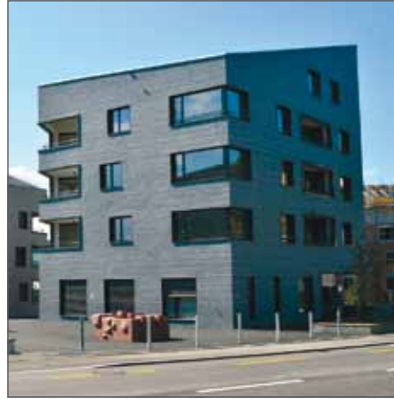
Markante Linien der Dachkanten und die Betonung der Fenster und Loggia-Ausschnitte durch Metallrahmen sind der Kontrapunkt zu der feingliedrigen Fassade.
