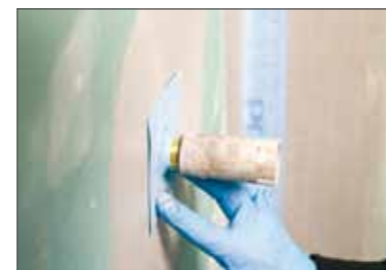
Abb. 3: Korrekt anliegende Dichtmanschette an einer Rohrdurchführung
