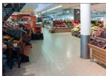
Der alte Bodenbelag des Frischemarktes (Foto oben) war kleinteilig und an einigen Stellen durch Warentransporte und die Kunden-Frequenzierung unansehnlich geworden. Nach der Renovierung präsentiert er sich dank der Fliesenformate modern und großzügig.
