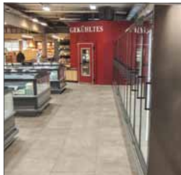
Der alte Bodenbelag des Frischemarktes (Foto oben) war kleinteilig und an einigen Stellen durch Warentransporte und die Kunden-Frequenzierung unansehnlich geworden. Nach der Renovierung präsentiert er sich dank der Fliesenformate modern und großzügig.
