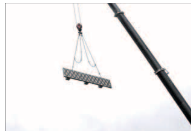
Entstanden ist das Projekt in Fertigteilbauweise. Die Elemente wurden mit einem Kran an ihre jeweilige Einbaustelle gehoben. Rechts ein Modell der Architekten, das die Lage des Altenheims in dem Komplex zeigt (dunkelgrau).
