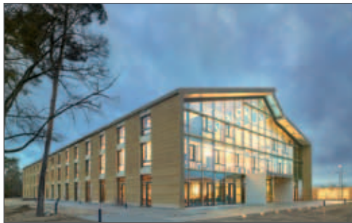
Nominiert für den Deutschen Nachhaltigkeitspreis ist unter anderem dieser Neubau mit einer Stampflehmfassade (Foto: Roland Halbe).
