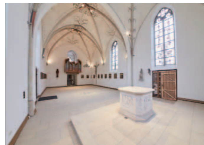
Der helle Natursteinbelag aus Baumberger Sandstein mit seinem unregelmäßigen Fugenraster sorgt für eine freundliche und einladende Atmosphäre. Die Kirchenbänke wurden verklebt, um Bohrlöcher zu vermeiden.
