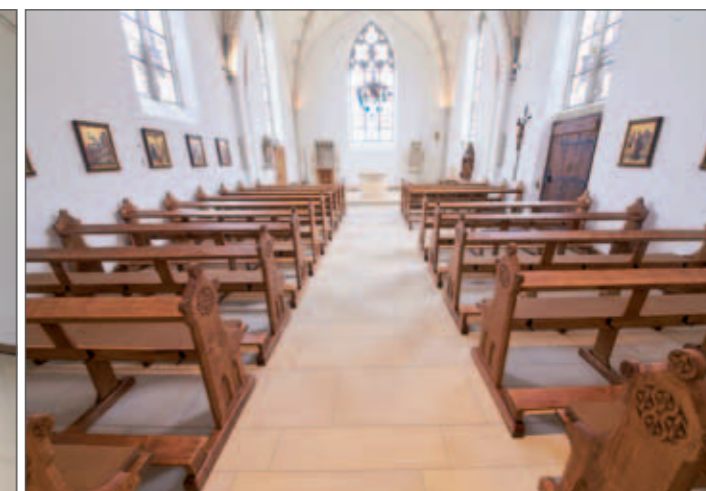
Der helle Natursteinbelag aus Baumberger Sandstein mit seinem unregelmäßigen Fugenraster sorgt für eine freundliche und einladende Atmosphäre. Die Kirchenbänke wurden verklebt, um Bohrlöcher zu vermeiden.
