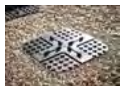
Das neue Plattenlager wird auf das Splittbett im Kreuzungspunkt der Platten gelegt und mit Fliesenkleber versehen. Noppen sorgen für gleichmäßige Fugenbreite.
