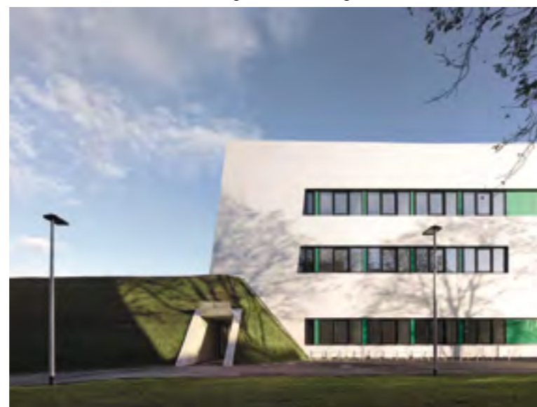
Das eingeschossige Fassadenende steckt komplett in dem grünen Hügel, der die äußeren Wärmelasten und die magnetische Strahlung reduziert.
