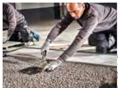
Das neue Plattenlager wird auf das Splittbett im Kreuzungspunkt der Platten gelegt und mit Fliesenkleber versehen. Noppen sorgen für gleichmäßige Fugenbreite.
