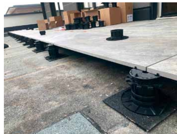
Ein Universalclip wird auf dem Kopf des Stelzlagers befestigt und verhindert den Kontakt zwischen dem Bodenbelag und der Wand.
