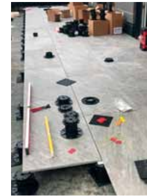
Vorteil für die Stelzlager: Die Baustelle bleibt trocken, was insbesondere auf Balkonen und Dachterrassen vorteilhaft sein kann. Trotzdem lauert der Teufel im Detail, weil der Höhenausgleich besonders sorgfältig ausgeführt werden muss. Sonst wackelt es.
