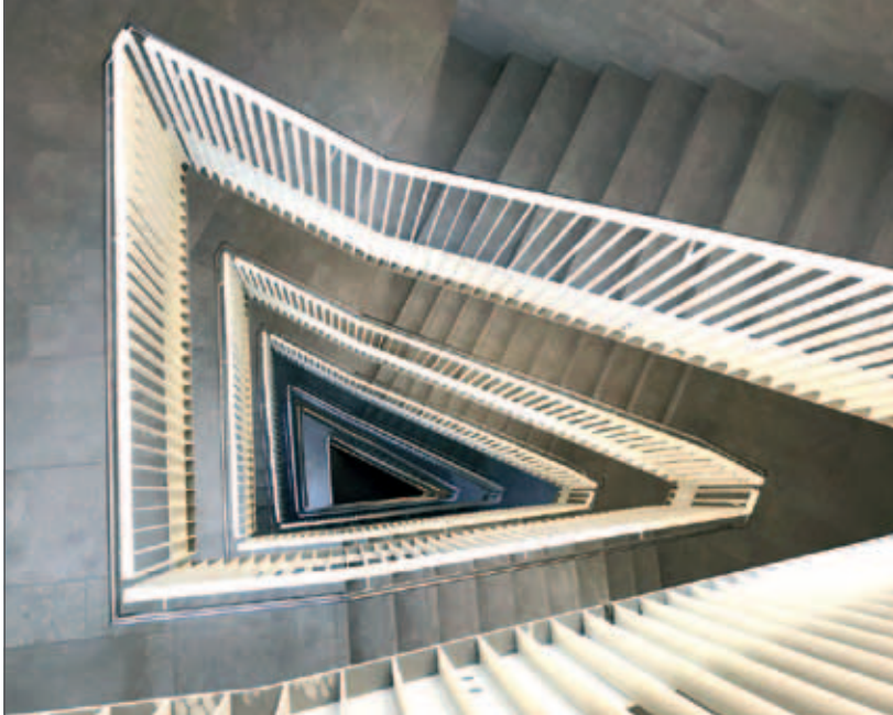
Auch das Treppenhaus folgt der ikonischen Form der Fassade und gleicht von oben betrachtet einer Skulptur
