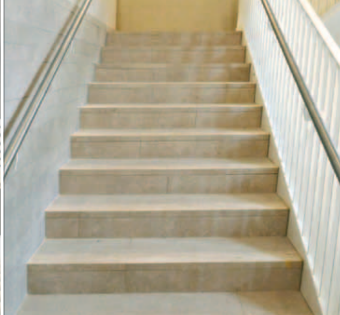
Aus der Nähe betrachtet erkennt man die Marmorstruktur der Feinsteinzeugfliesen. Sie wurden auch an Teilen der Wandflächen verlegt
