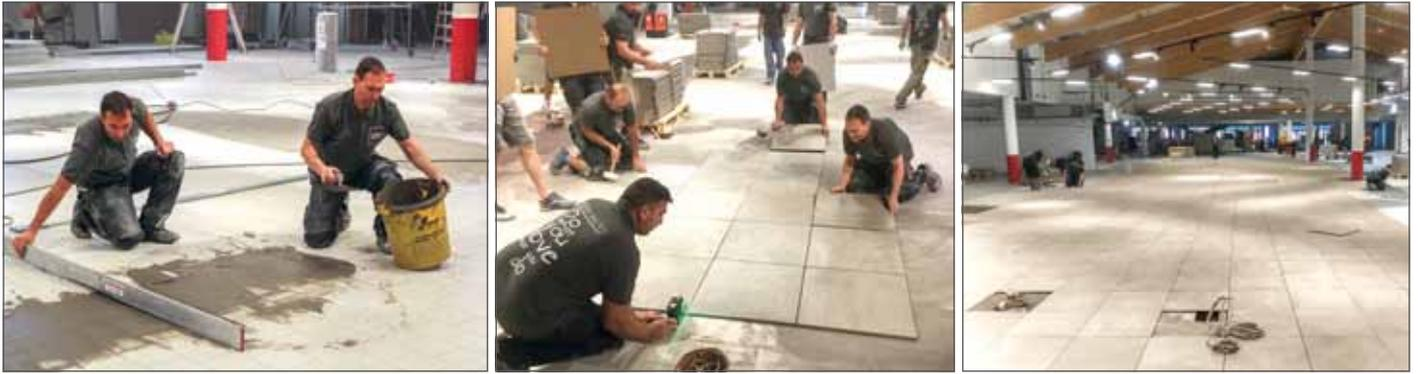
Die wichtigste Voraussetzung für trockene Verlegung der Fliesen ist ein planebener Untergrund, der durch Schleifen und Spachteln erreicht wurde (linkes Bild). Die Verlegung danach war dank der großen Fläche unproblematisch.
