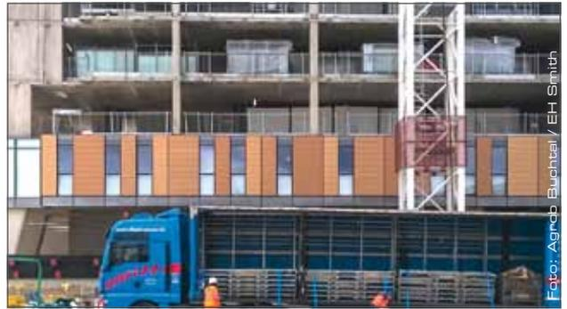
Über 100 LKWs lieferten die vorgefertigten Elemente zeitlich exakt getaktet an die Baustelle. Eine typische Ladung umfasste dabei 18 Regel-Elemente (3 x 6) auf Stahlpaletten.
