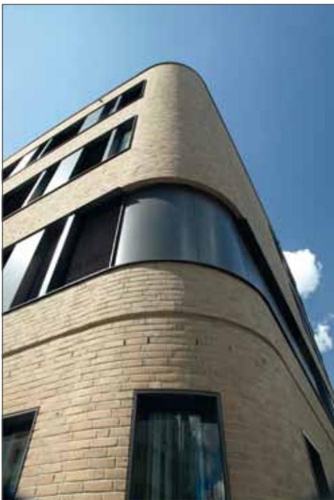
Der Baukörper ist an fast jeder Ecke anders. An der Nordseite (links) wird die Fassade von harmonischen Rundungen bestimmt, an der gegenüberliegenden Seite ist es ein spitzer Winkel, dem trapezförmigen Grundstück geschuldet. Das erforderte viele Sonderformate.
