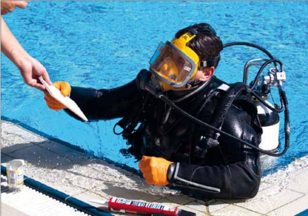
Wenn sich am Schwimmbadboden plötzlich Fliesen lösen, ist der Schaden an sich oft überschaubar. Schwieriger sind die Begleitumstände, da das Becken zur Sanierung trocken gelegt werden muss. Wird zur Behebung kleiner Schäden ein Hybrid-Polymer-Kleber verwendet, kann die Reparatur auch unter Wasser erfolgen.
