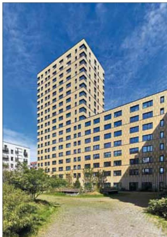
Die speziell entwickelten und gefertigten keramischen Schenkelpplatten ermöglichen technisch und optisch stringente Ecklösungen, die der Gebäudehülle souveräne Homogenität verleihen.
