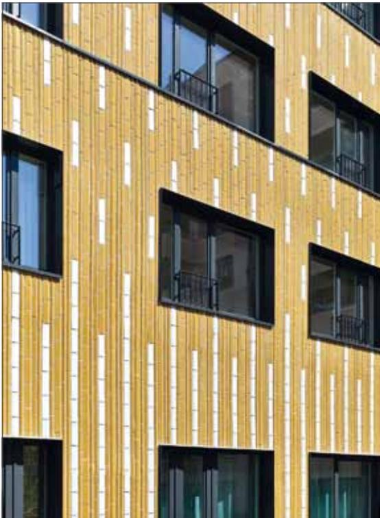
Besondere Aufmerksamkeit der Architekten galt den Gebäudeecken. Um den Keramikbelag nicht als dünne Fassadenfläche erscheinen zu lassen, sondern als homogenen keramischen Maßanzug, wurden eigene Formteile dafür entwickelt.
